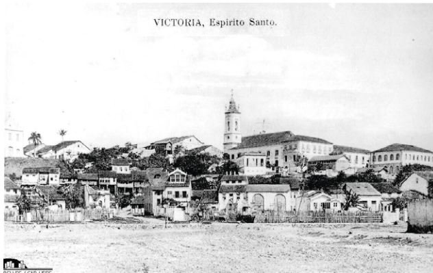
Figura 1 – Parque Moscoso. Rua General Osório, próximo ao atual Centro de Saúde. No alto, a Igreja de São Gonçalo (esquerda) e Palácio do Governo (centro). Autoria: [Autor Desconhecido, 1908]
